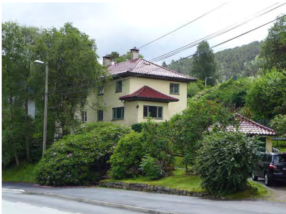
Figur 47. Vertikalt delt tomannsbolig oppført i 1947 langs Eidsvågveien. Arkitekt Paul Lambach (Eidsvågveien 144) (foto: Byantikvaren 2016).
