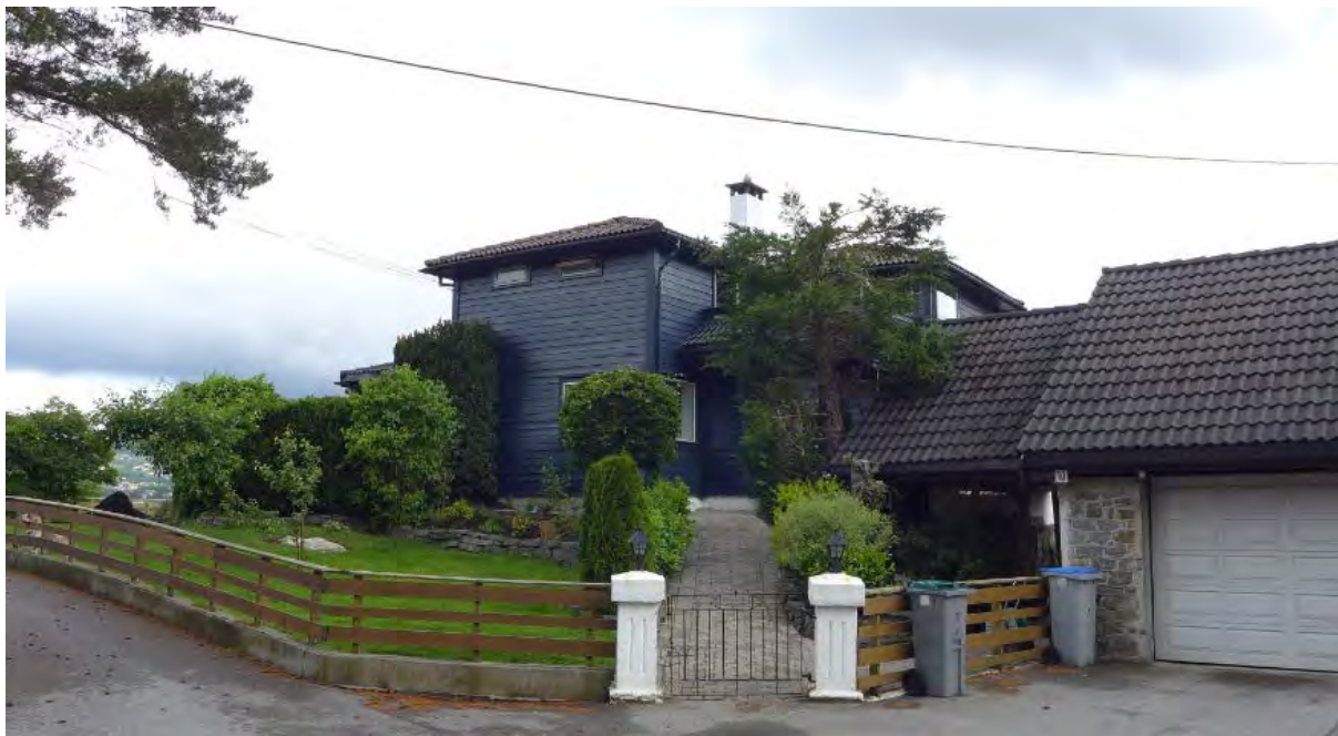
Figur 38. Villa «Nye Schøtstuen» i Kongleveien 10 ble tegnet av arkitekt Odd Lahn Johannesen i 1938 (foto: Byantikvaren 2016).
