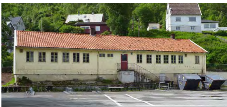
Figur 44. Den ene av to bevarte brakker fra den tyske forlegningen på Myrane ligger i dag på skoleplassen til Eidsvåg skole, like utenfor planområdet. Brakken var administrasjonsbrakke i leiren. Etter krigen ble den innredet til klasserom for skolen. Eksteriøret til brakken er svært godt bevart og bygningen har høy verneverdi (Foto: Byantikvaren 2016).
