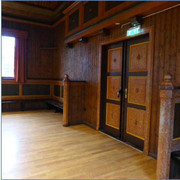
Figur 105. Flotte detaljer i det opprinnelige interiøret i forsamlingslokalet. Her en original døråpning og benker langs veggene i salen (Foto: Byantikvaren 2015).
