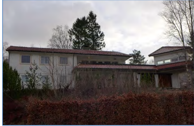
Figur 71. Typehus fra Florvaag Bruk As, Nebbeveien 18 (Foto: Byantikvaren 2015).
