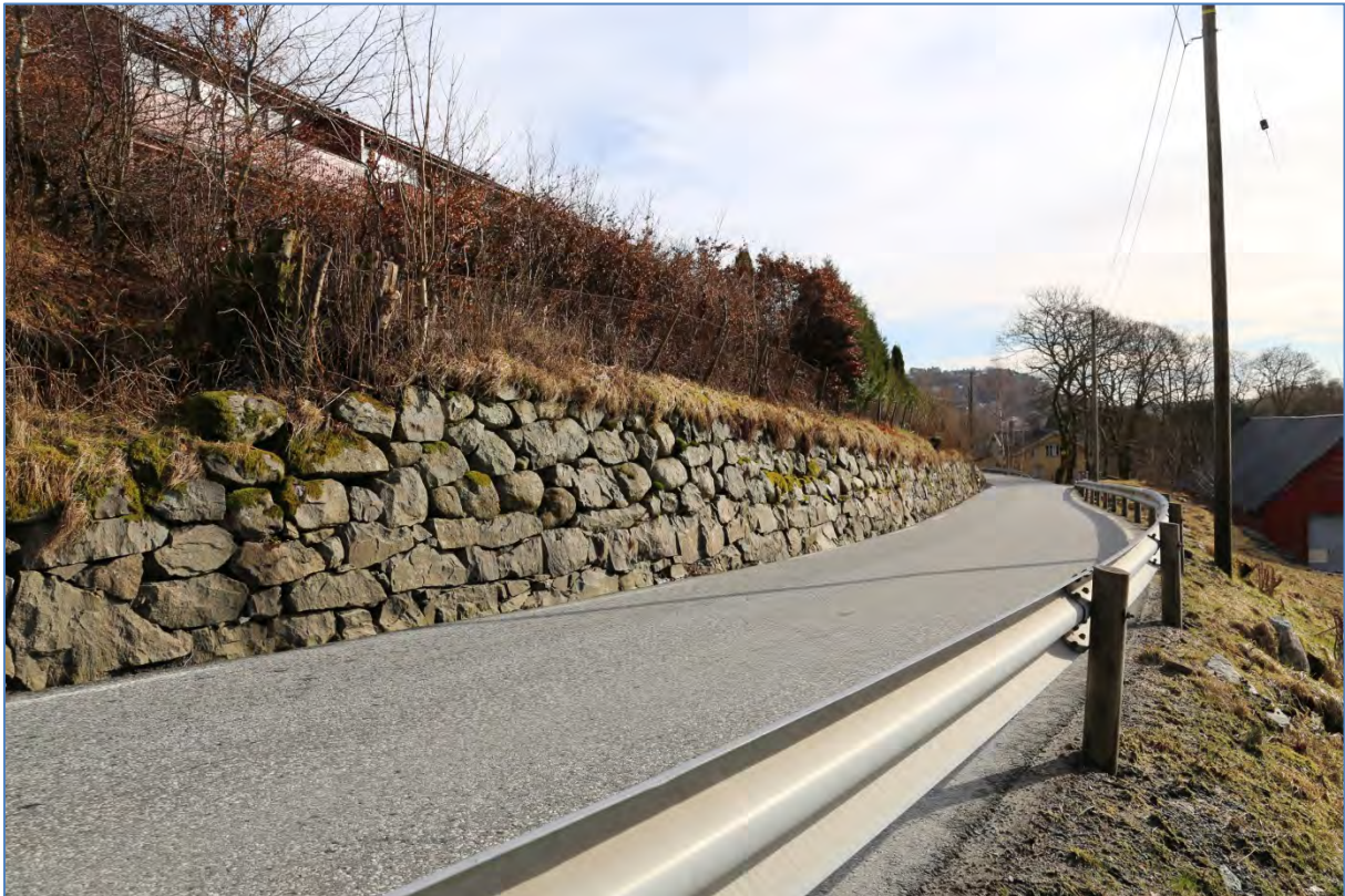
Figur 19a: Tørrmurte støttemurer langs Sæleveien, ved Sælen gård (Foto: Byantikvaren 2015).
