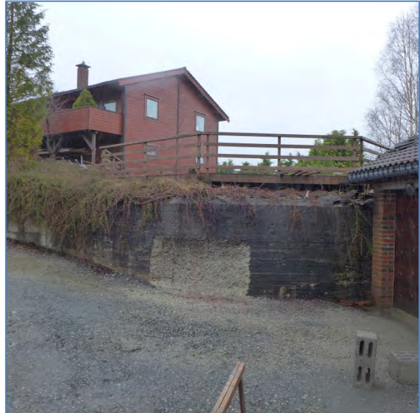
Figur 96. Fundament for luftvern skyts integrert i en hage i boligområdet (Foto: Byantikvaren 2015).
