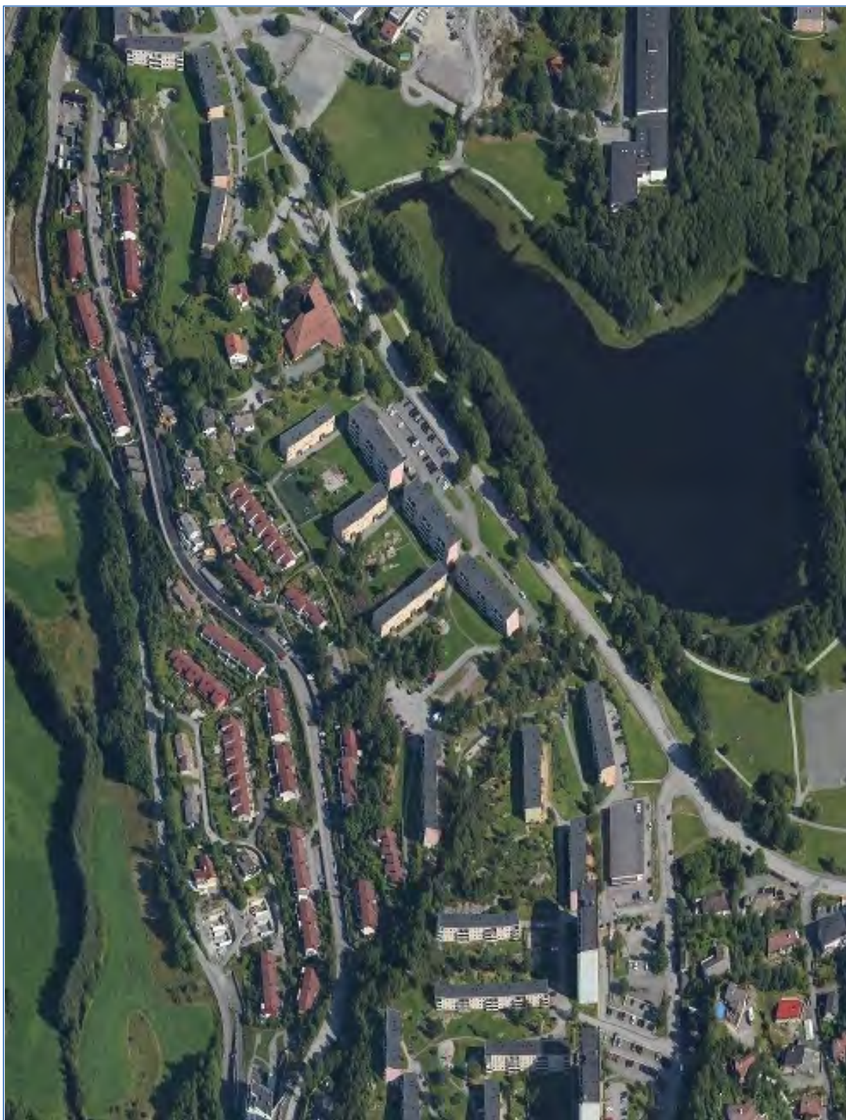
Figur 28. Bakkane borettslag til venstre, lav- og høyblokkene til Smiberget til høyre (Ortofoto, Bergen kommune).
