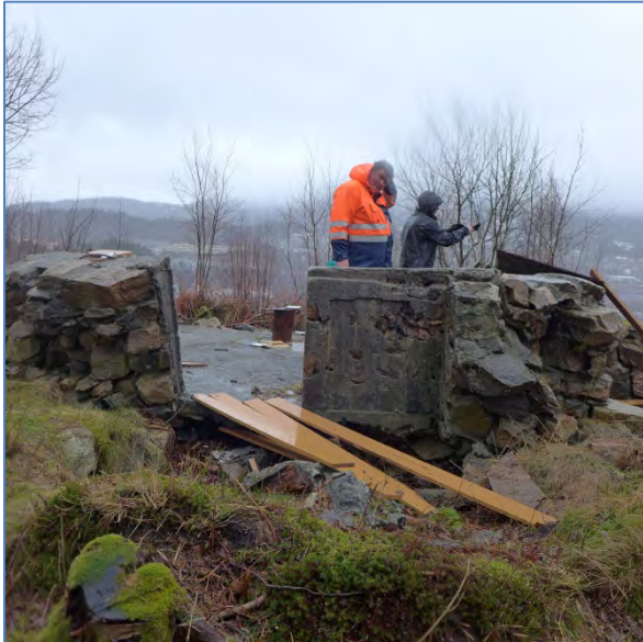
Figur 95. Fundament for maskinkanon (Foto: Byantikvaren 2015).
