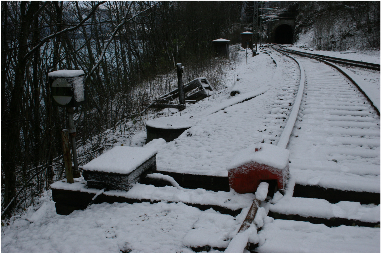
Tunes sporveksel med apparatskap og signalhus i bakgrunnen. Foto: Byantikvaren
