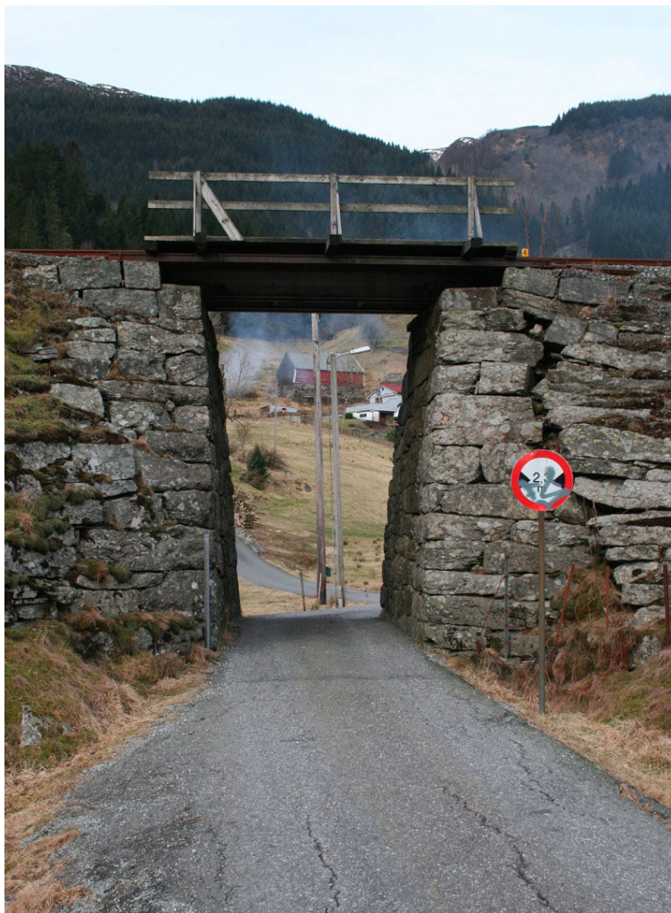
Undergang ved Bratland. Setningskader i brokaret til høyre. Foto: Byantikvaren
