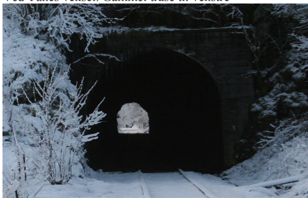
Endret tunneltak-profil for elektrisk togdrift
