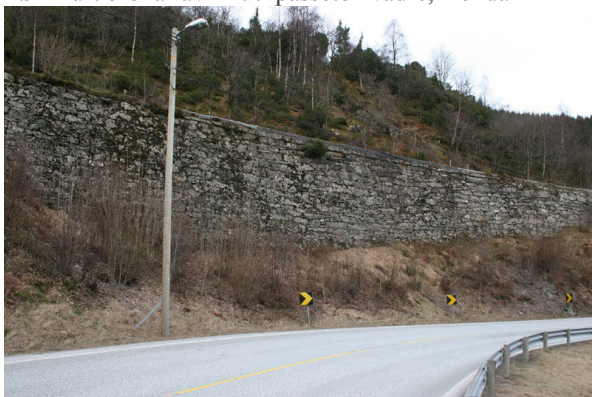
Tørrmurt forstøtningsmur ved Grimen
