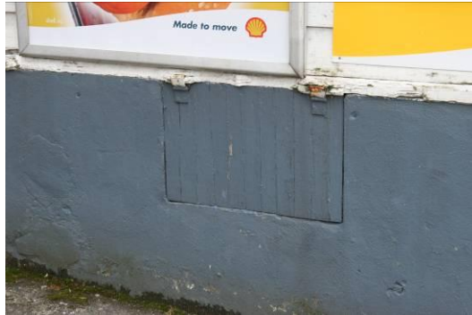
Verksted med 2 nye gruer – med lem ut mot plassen. Her ble hestekoene lagt inn i essen og hestene skodd på utsiden. Foto Byantikvaren 2009
