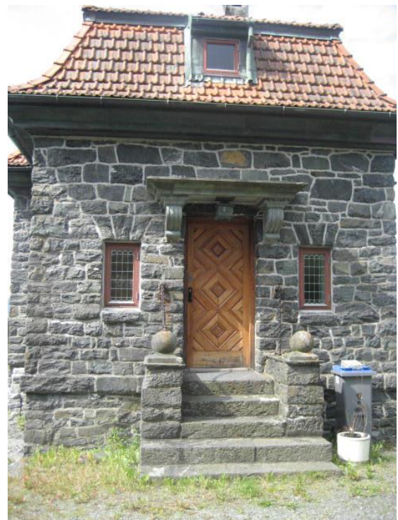
Foto Norconsult 2011. Inngangsdør øst.
