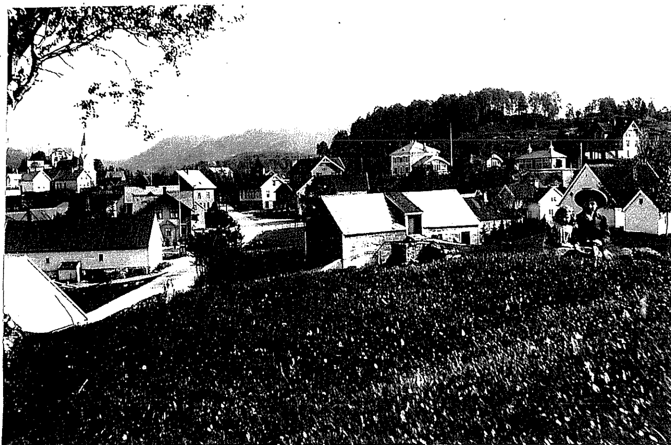
Nesttun sentrum sett fra nord våren 1907. I forgrunnen ser vi de to brukene under Nesttun. Bruk nr.11 ligger til høyre. Foto er hentet fra kalender utgitt av Fana historielag.
