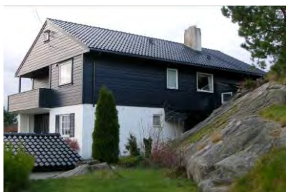
Øvre Bergveien 10C: 1966. Bygningsnr 139422392. Sone 7
