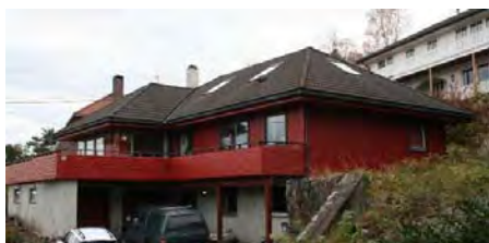
Kråkenesveien 75: 1987. Bygningsnr 9466096. Sone 4
