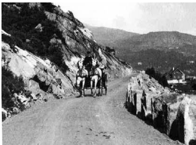
Fig.66. Strømmevegen i 1901 (mot nordøst)
