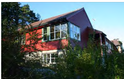
Kråkenesveien 65: 1936. Bygningsnr 139418085. Sone 4 Tomannsbolig
