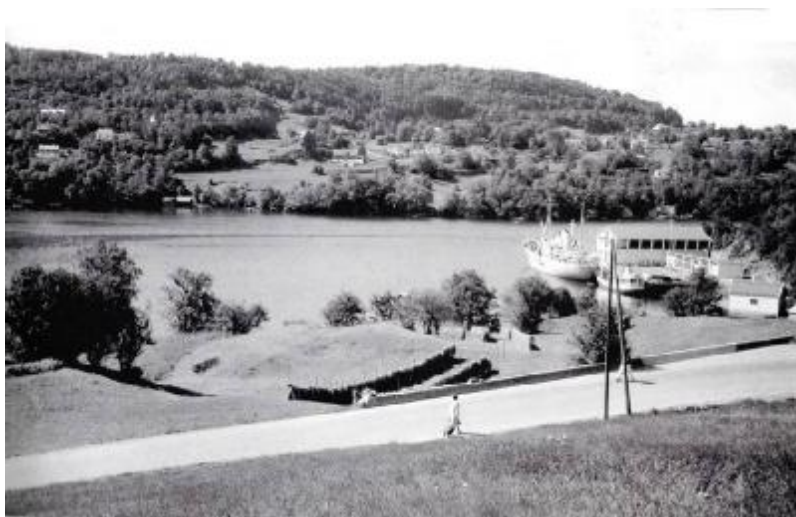
Søreide sommeren 1961 med Televerket sin bygning og kabelbåter Fra: "Fana- slik det engang var"
