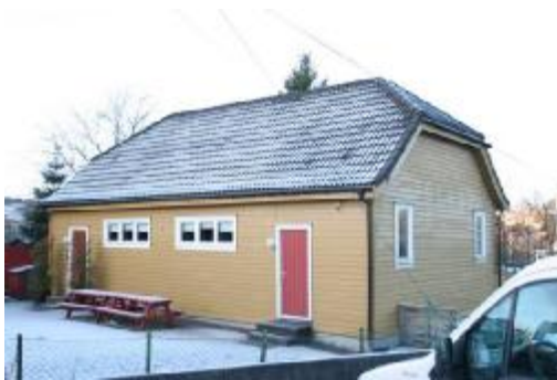
Tidligere ungdomshus, nå i bruk som SFO Foto: Byantikvaren
