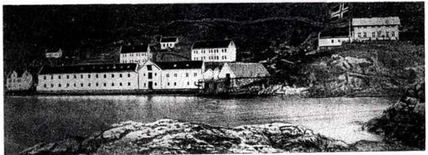
Salhus Tricotagefabrik Efter fotografi fra 1866
