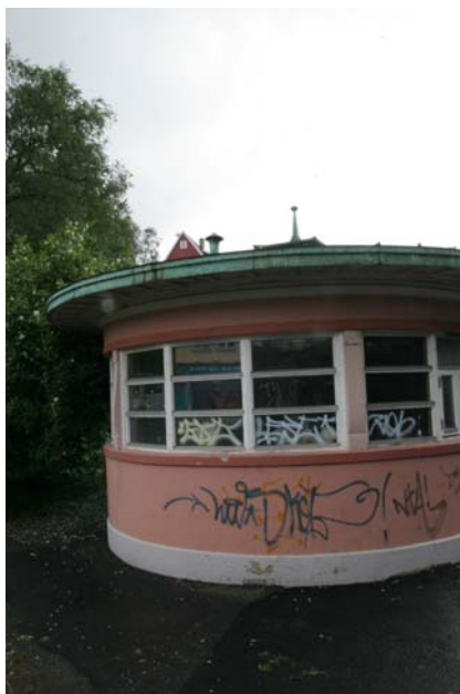
Sporveiskiosken sett fra nord
