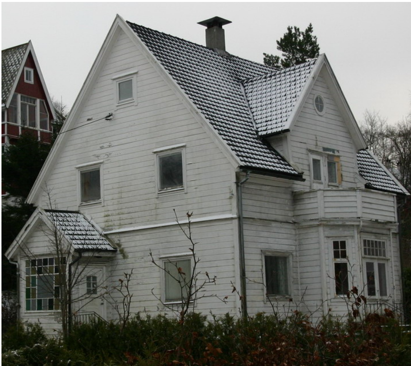
Under: Nyhaugveien 4, oppført 1923. Begge i nyklassisistisk uttrykk.
