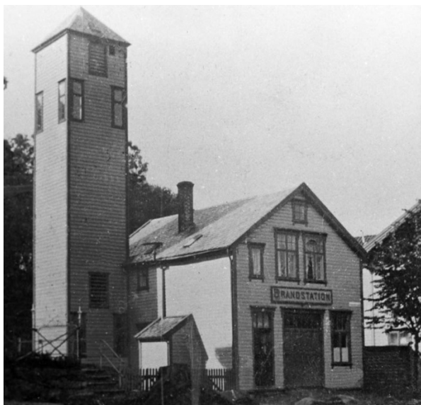
Figur 81. Laksevåg brannstasjon i Håsteingate ble åpnet i 1907. Stasjonen hadde slangetårn og garasjeanlegg for brannvogner (Kilde: http://www.touristphoto.no ).
