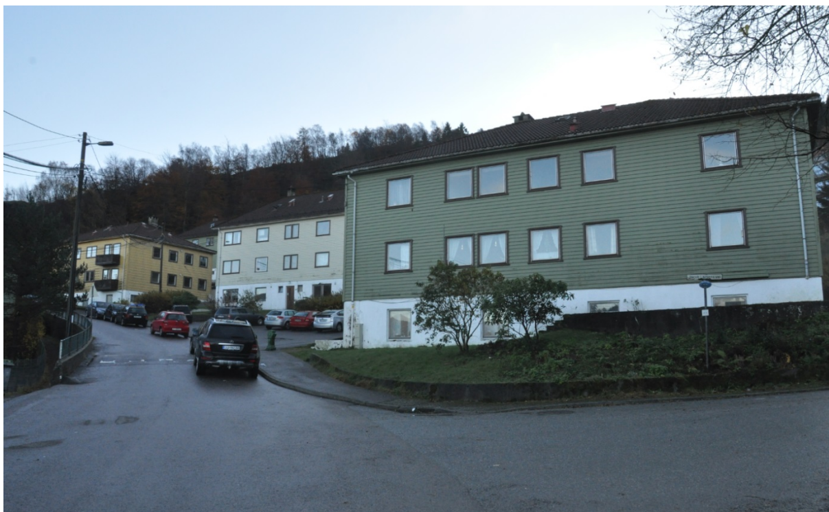
Figur 108. Bevarte brakker fra den tyske forlegningen i Vågedalen. Brakkemiljøet er besluttet revet til fordel for et nytt boligprosjekt (Foto: Byantikvaren 2016).
