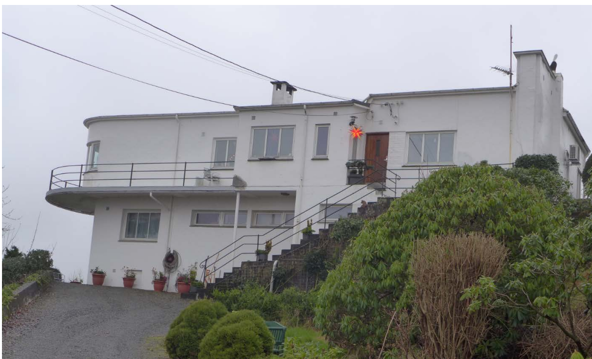
Figur 72. Funkisvilla på oppført i 1933 (Johan Berentsens vei 159). Arkitekt ikke oppgitt i kommunens byggesaksregister (Foto: Byantikvaren 2016).
