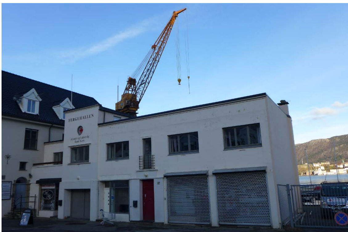
Figur 8. Fergehallen ble oppført som publikumsterminal og administrasjonsbygning for Laksevåg kommunale Ferge- og Rutebilselskap i 1940, og er tegnet av arkitekt Ole Olsen (Foto: Byantikvaren 2017).
