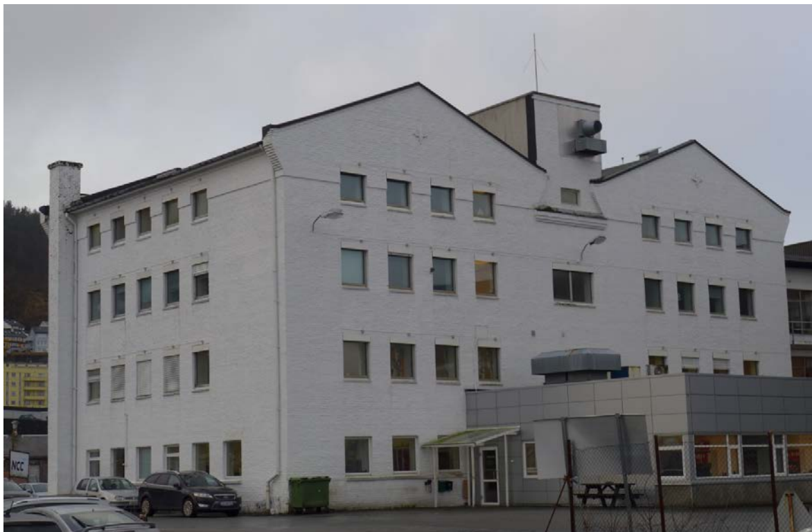
Figur 105. Tyskbygde fabrikkbygninger på Laksevågsneset (Foto: Byantikvaren 2016).
