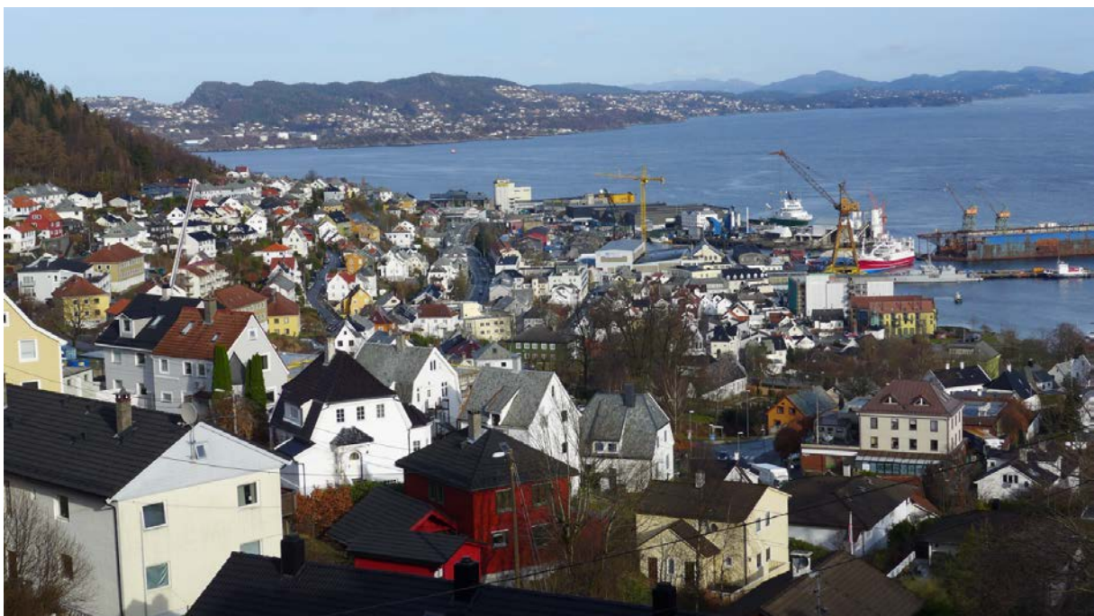
Figur 37. Bildet viser taklandskapet i dagens bebyggelse i indre Laksevåg. Det er et tap for kulturmiljøet at opprinnelig skifer og tegl forsvinner når takene tekkes med stein og takplater som ikke er tilpasset husenes egenart (Foto: Byantikvaren 2016).
