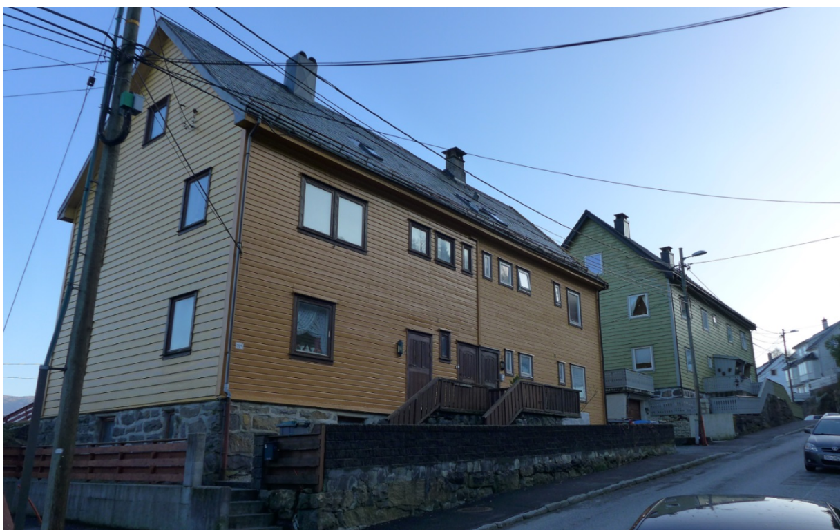
Figur 62. Store arbeiderboliger oppført for A/S Laxevaas maskin- og jernskibsbyggeri i 1920 i Lille Damsgårdsvei Arkitekt Olai Schumann Olsen (Foto: Byantikvaren 2017).
