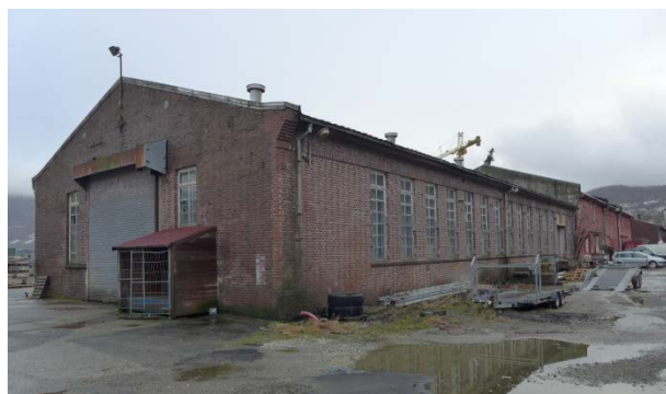
Figur 107. Verkstedene ble oppført av den tyske okkupasjonsmakten under 2. verdenskrig (Foto: Byantikvaren 2016).
