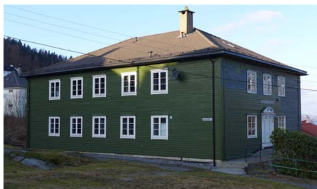
Figur 111. I dag brukes en tysk mannskapsbrakke ved Damsgård hovedgård som speiderhus (Foto: Byantikvaren 2016).
