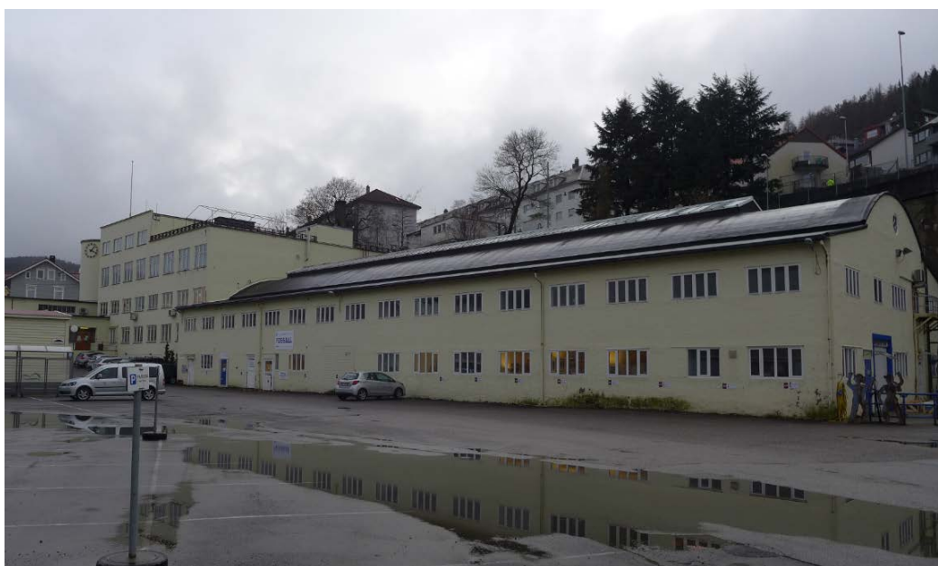
Figur 35. Lagerbygningen (1950) på nordsiden av administrasjonsbygningen er et godt tilpasset tilbygg (Foto: Byantikvaren 2016).
