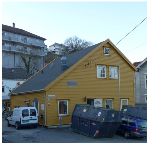
Figur 82. Den gamle brannstasjonen er bevart i dag, men slangetårnet er revet og hovedbygningen har fått en utvidelse mot sør (Foto: Byantikvaren 2016).
