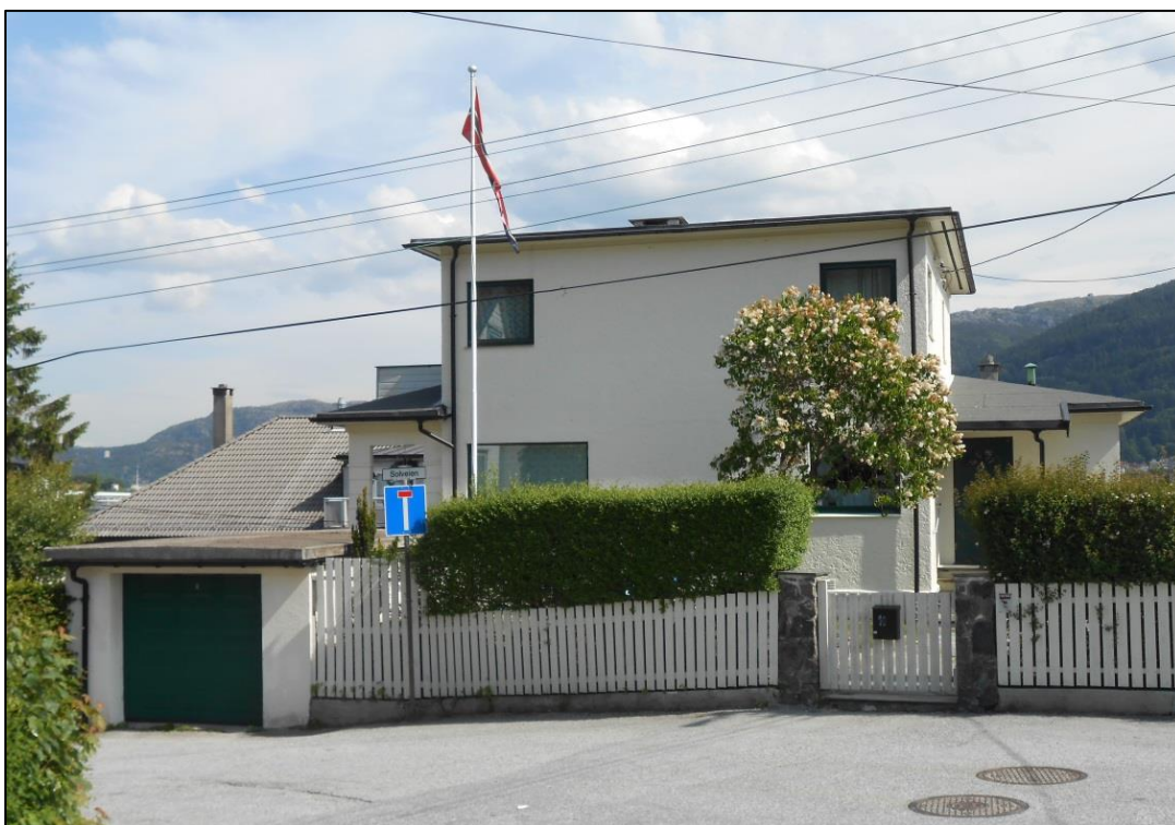
Figur 22. Selveien 10 (1939). Murvilla oppført for Hr. Fabrikkmester Lunde i funksjonalistisk stil (Foto: Byantikvaren 2014).
