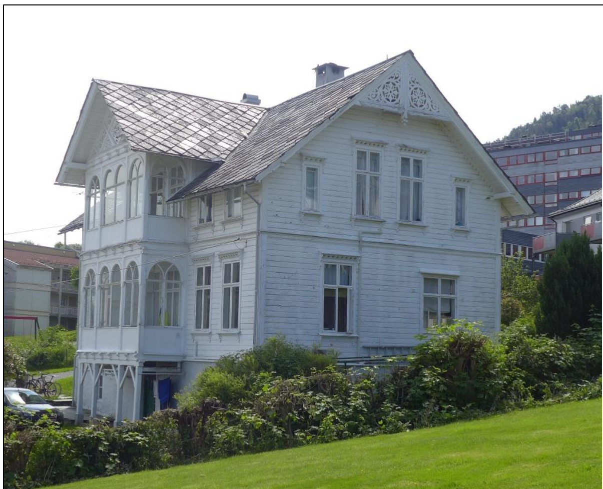
Figur 31 I Frydenbølien 13 ligger en sveitservilla fra ca 1880 i grønne omgivelser (Foto: Byantikvaren 2014).
