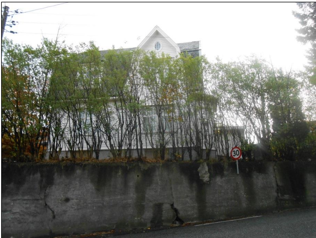
Figur 17 Fyllingsveien 28. Villa fra 1910-tallet (Foto: Byantikvaren 2014)
