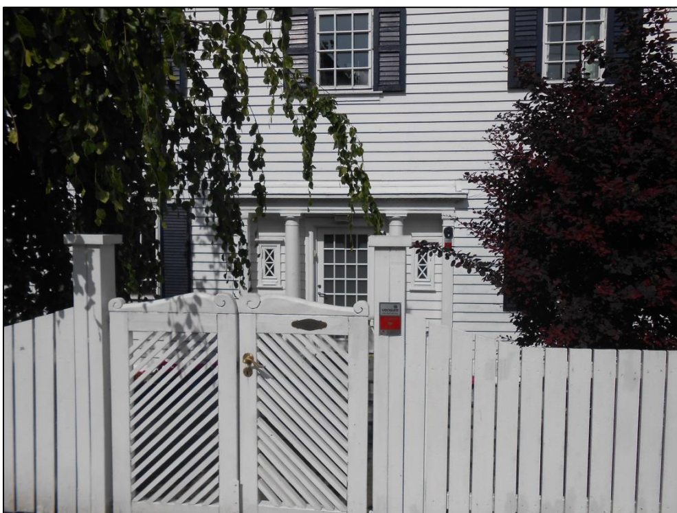
Figur 36 Nylundsveien 6, oppført 1929, er en helhetlig eiendom med søylebåret inngangsparti, inngjerding og port i husets stil (Foto: Byantikvaren 2014)
