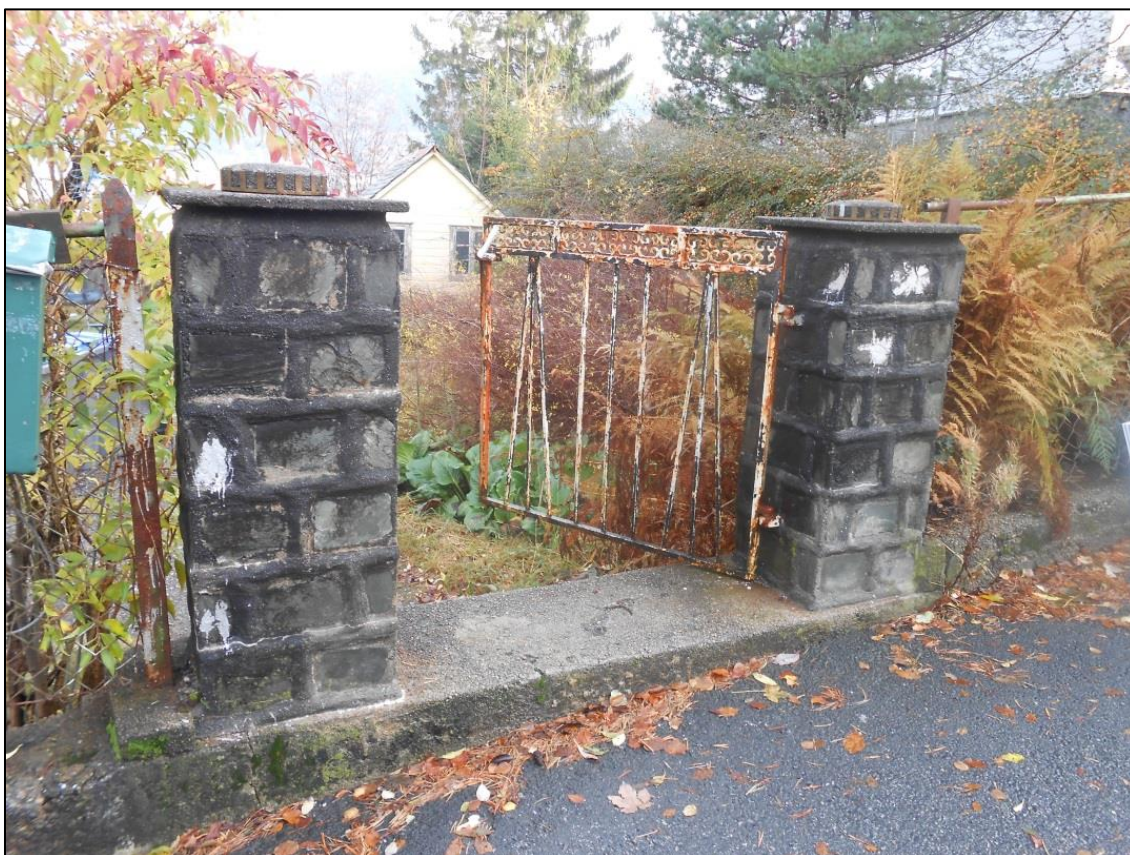
Figur 40 Port i Solveien (Foto: Byantikvaren 2014)
