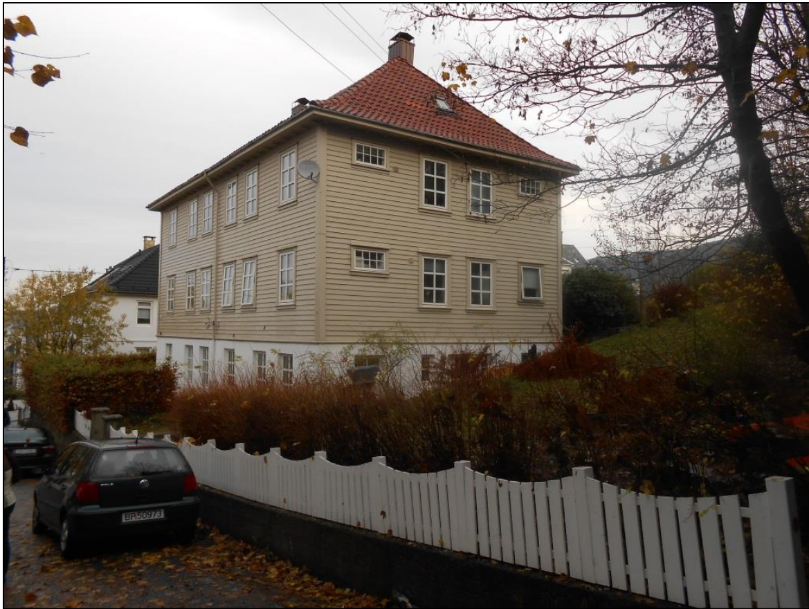
Figur 34 Alléen 16-18, oppført 1929. Tannsnittbord oppunder gesimsen (Foto: Byantikvaren 2014).
