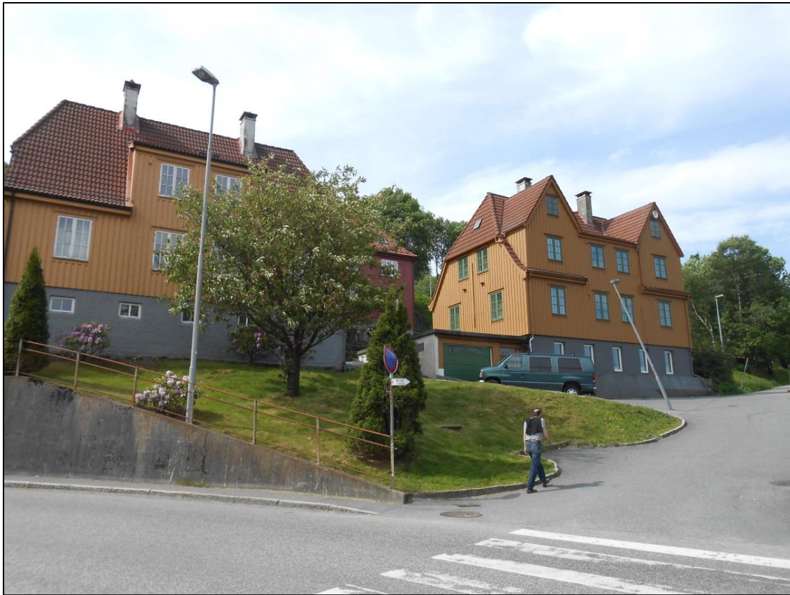
Figur 32 Blodbyen/Gyldenprisveien 9-17 og Lien 85 (1916). I dag er bare 6 bygninger av den en gang så store brakkebebyggelsen bevart (Foto: Byantikvaren 2014)
