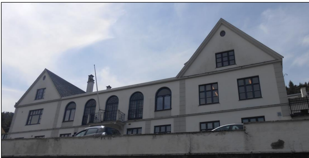
Figur 42 Gyldenprisveien 16, Høyenes Vinfabrikk. Murbygningen er fra 1927 og tegnet av Ole Landmark (Foto: Byantikvaren 2014).
