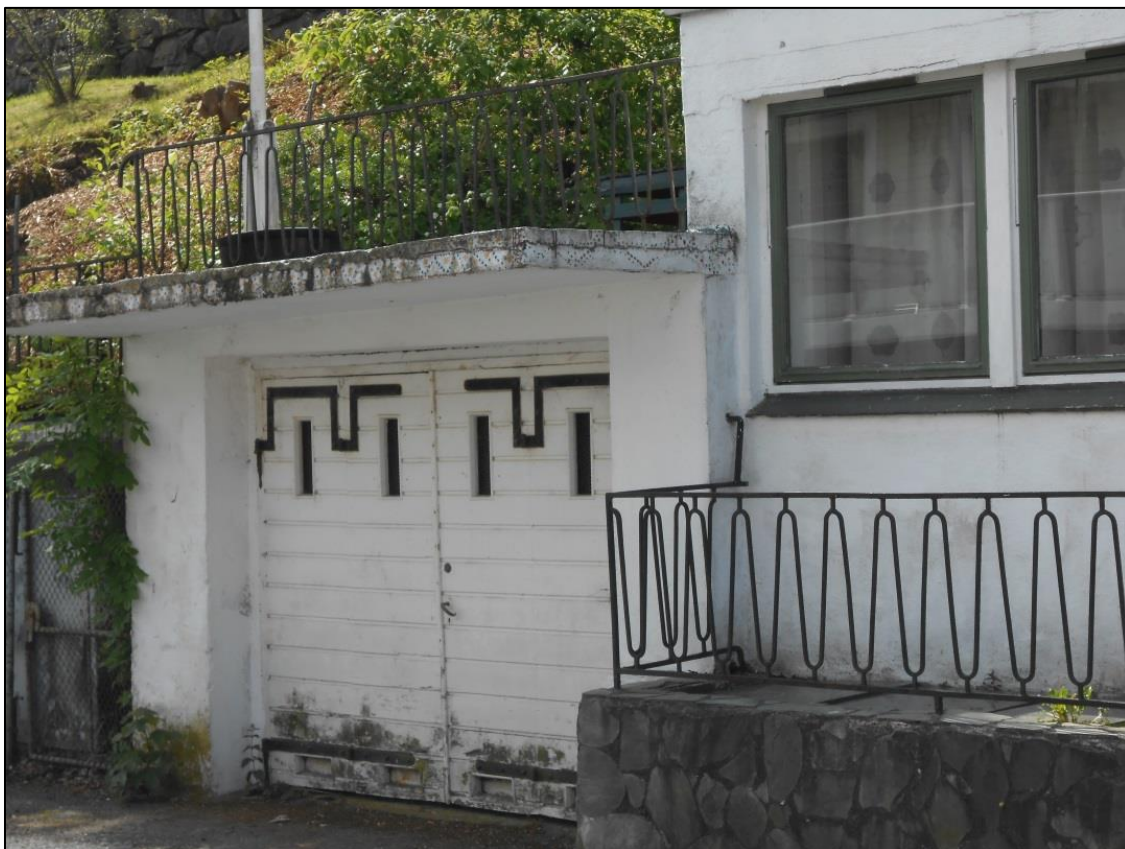
Figur 20 Nylundsveien 27. Garasjen er oppført 1946 og er et sjeldent godt bevart eksempel på tidlige garasjebygninger (Foto: Byantikvaren 2014)
