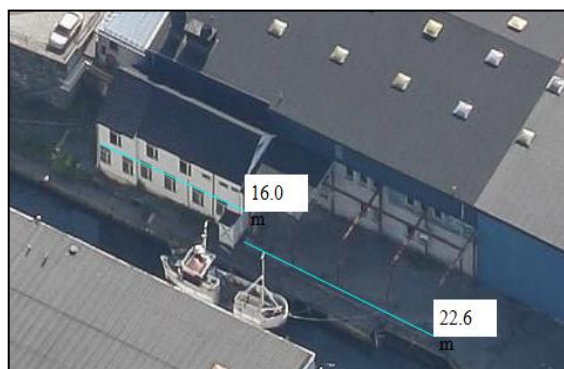
Figur 3: Dokkhuset. Eksisterende stålkonstruksjon (ca. 20 meter) angir grense for ønsket utvidelse mot sør.
