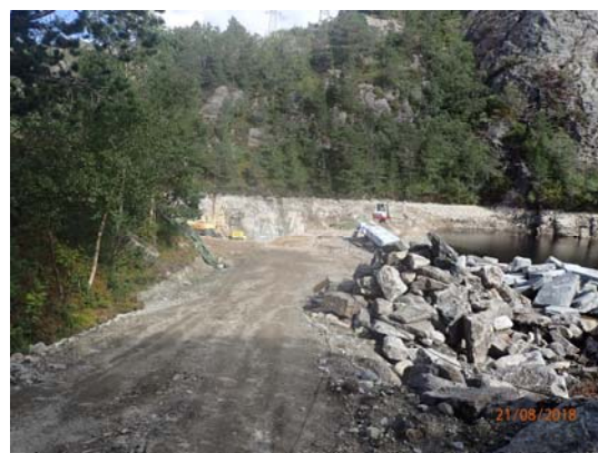
Bilde 6, etablering av flomløp på fangdammen
