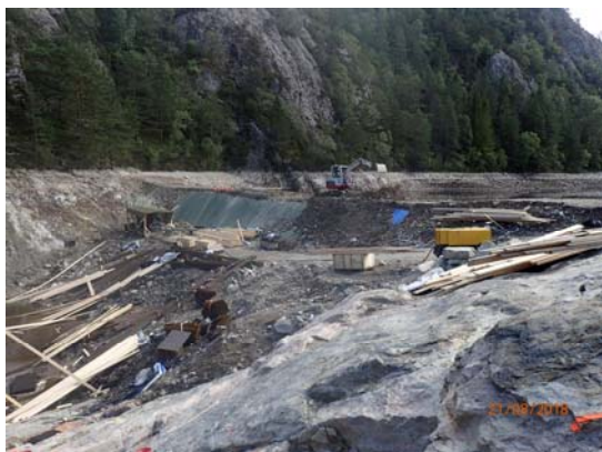
Bilde 3, gravemaskin etablere flomløp på fangdam
