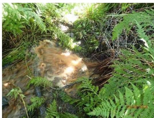
Bilde 2, tapping gammel vannledning startet (brunt vann)
